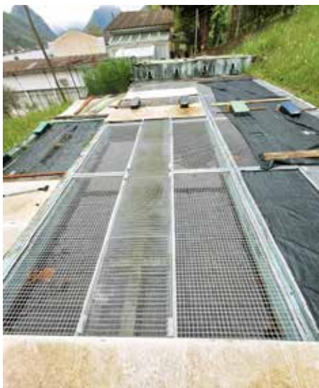
Effettuata la copertura della piscicoltura a Brusino Arsizio con griglie zincate e finestre a ribalta (foto di Mario Della Santa).
