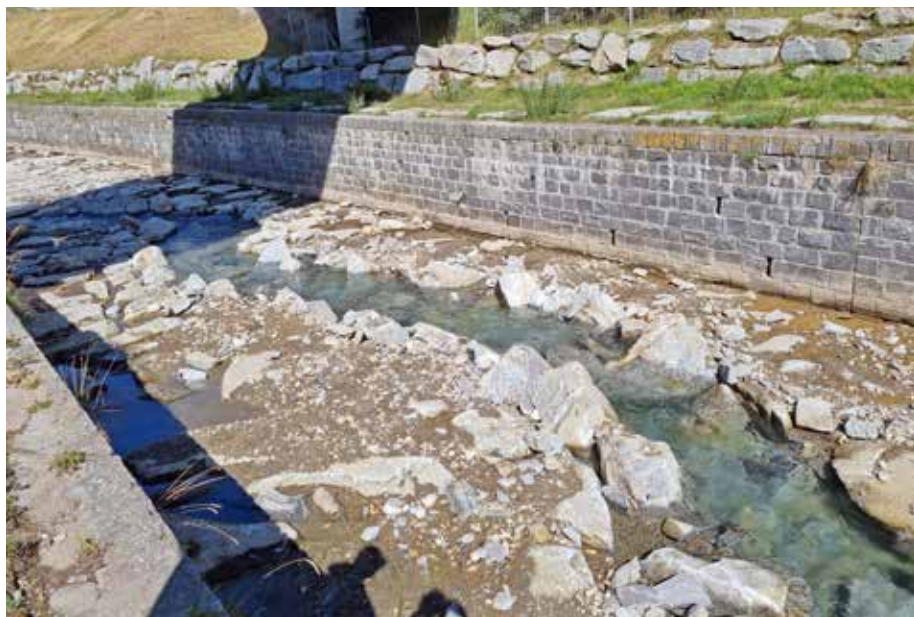
Il canale di magra è stato realizzato in modo sinuoso e con diverse pezzature dei blocchi, in modo che siano presenti le condizioni per lo stazionamento e il passaggio dei pesci.
