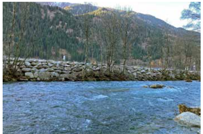
L'arginatura è stata portata in quota di protezione e la strada d'argine riprofilata.
