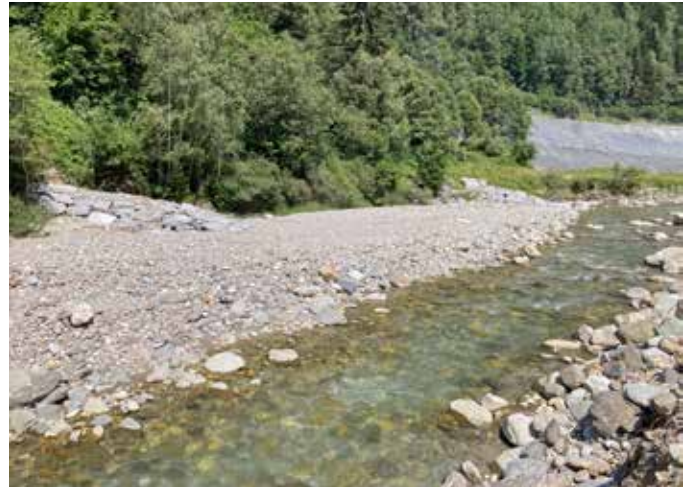
Sullo sfondo della foto i pennelli che, durante l'evento di piena di fine giugno dell'anno scorso, hanno già aiutato il fiume a riprendersi parte dello spazio destinato alla golena in sponda destra.
