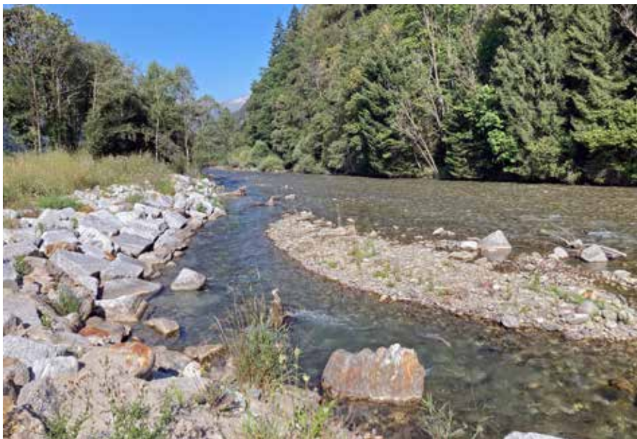
I due allargamenti realizzati a Piotta hanno già permesso al fiume di creare dei bracci secondari.
