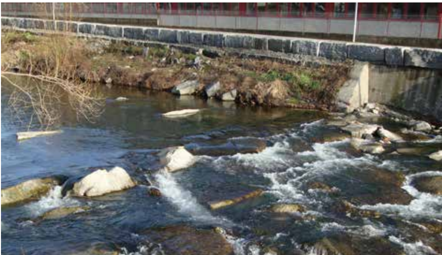
Lotto 4A – Una delle 10 rampe in blocchi realizzate nel 2010 nel tratto di fiume tra Mezzovico-Vira e Monteceneri/Camignolo per favorire la risalita ittica, laddove erano presenti delle briglie che costituivano un ostacolo per la fauna e che presentavano forti erosioni alla fondazione (rampa al km 13.475 dalla foce; foto del gennaio 2011).
