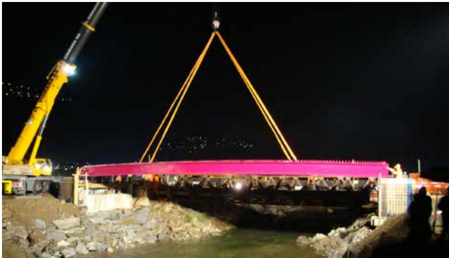
Lotto 5 – Ponte stradale in località ai Mulini di Bioggio. Nella foto, il momento della posa di una delle travi principali del manufatto (foto del 16 aprile 2010).
