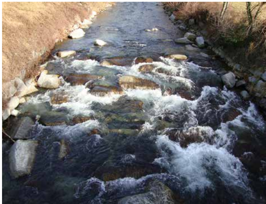
Lotto 4A – Rampa al km 14.263 dalla foce, a Monteceneri/Camignolo (foto nel gennaio 2011).
