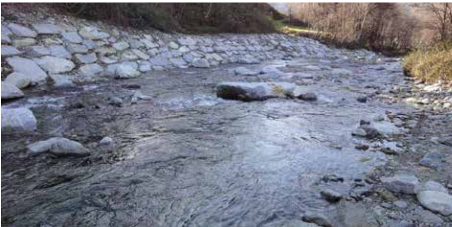
Lotto 4A – Il fiume Vedeggio sistemato nel 2009 a Monteceneri/Camignolo, dove erano presenti insufficienze idrauliche e forti erosioni delle sponde. Ben visibile la strutturazione del fondo del corso d'acqua per favorire la risalita ittica (foto del dicembre 2009).
