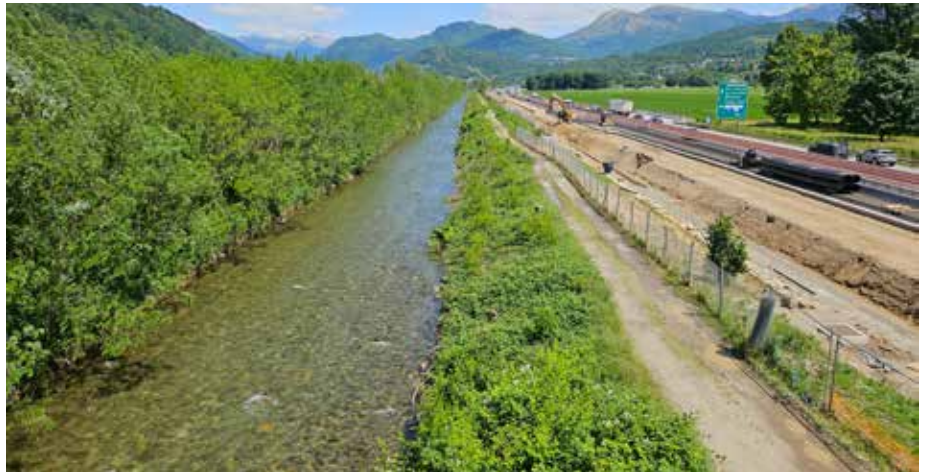
Lotto 2.1 – Tratto del fiume Vedeggio che sarà interessato – in base al messaggio approvato dal Parlamento nell'autunno scorso – dai prossimi lavori a Bioggio (foto scattata a maggio 2025).
