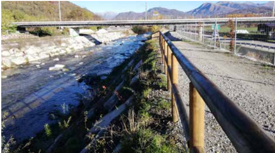
Lotto 1.3 – Tratto in prossimità del ponte della Ferrovia FLP a Bioggio, completato tra il 2021 e il 2022, dopo i lavori di sostituzione del collettore consortile che attraversa il fiume da parte del CDALED (foto del novembre 2022).
