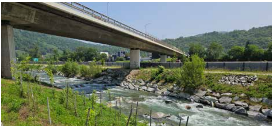
Lotto 2.2 – Tratto del fiume sistemato tra Lamone e Manno dal 2022 al 2024. Si notino le piantagioni di alberi ed arbusti nonché le pietraie per la piccola fauna nella parte alta della sponda, così come la strutturazione del fondo dell'alveo per contenere l'erosione e, al tempo stesso, favorire la risalita ittica durante le magre (foto del giugno 2025).
