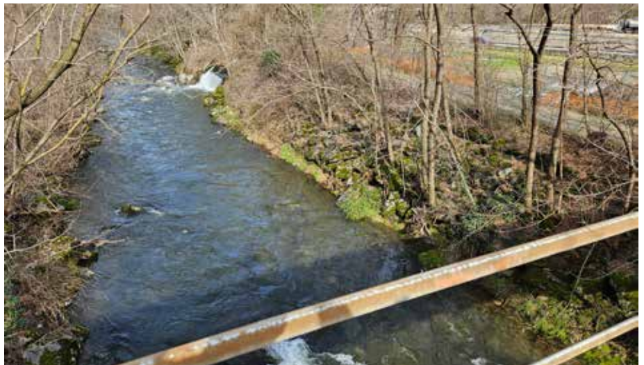
Lotto 2.1 – Tratto del fiume che sarà interessato dai prossimi lavori a Manno (foto risalente a febbraio 2024), visto dalla passerella tecnica collocata in prossimità della confluenza del riale Ponteggia/Gaggio.
