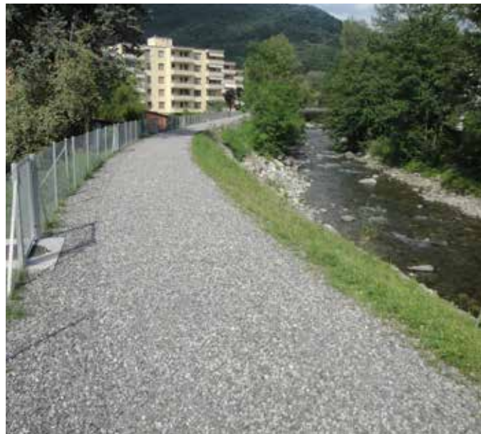
Lotto 4B – L'argine orografico destro realizzato a Taverna, durante i lavori eseguiti tra il 2011 e il 2013, permette di contenere le piene del fiume e consente il transito della mobilità lenta (foto del giugno 2014).
